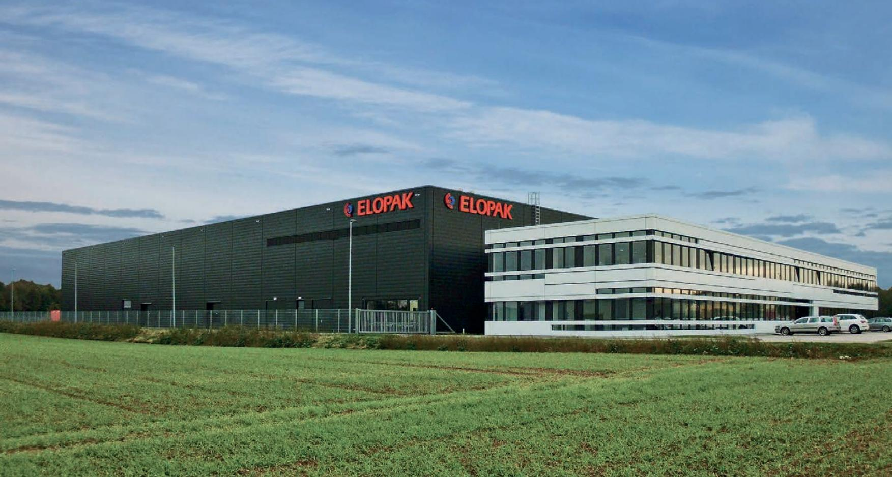
An der Fassade sind die beiden Bereiche Büro und Produktion ablesbar: Das zweigeschossige Bürogebäude präsentiert sich mit einem Wechselspiel von großformatigen weißen Aluminiumverbundplatten und mäandrierenden Fensterbändern. Die Hallenfassade ist mit einer schwarzen Metallfassade bekleidet. Beide Gebäudeteile ergeben eine kontrastreiche Einheit.
