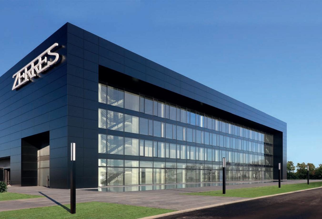
Der fünfgeschossige Baukörper zeigt sich in Form einer geschlossenen Box, in dem modernste Fördertechnik die Waren transportiert und sortiert. Der Bau öffnet sich mittels einer großflächigen Glasfassade und geht, über ein vorgelagertes Wasserbecken, fließend in die Außenanlagen über.
